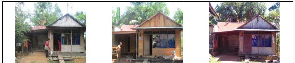
Gambar 3. 48. Pembangunan Peningkatan Kualitas Rumah Swadaya (DAK) Perumahan (Progress 100 %)
