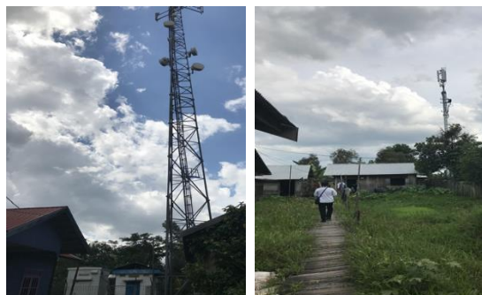
Gambar 3. 38. Pengendalian dan pengawasan menara telekomunikasi
