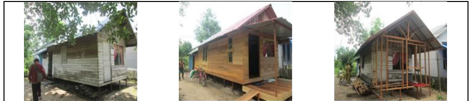
Gambar 3. 47. Pembangunan Peningkatan Kualitas Rumah Swadaya (DAK) Perumahan (Progress 0 %)
