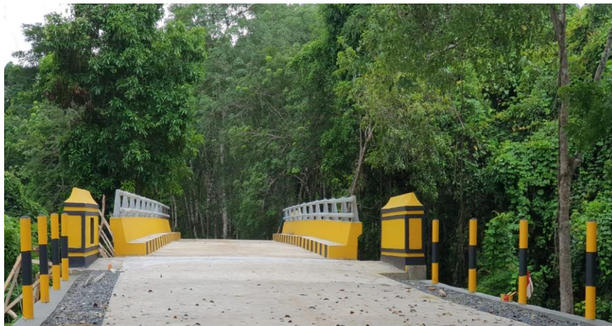
Gambar 3. 92. Rekonstruksi Jembatan Sungai Jati Kecamatan Mataraman
