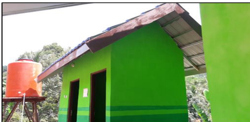
Gambar 3. 17. Pembangunan Sarana Air Bersih dan Sanitary WC Guru dan Siswa SDN Sungai Uyak, Sambung Makmur
