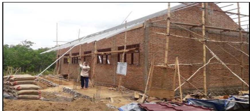
Gambar 3. 13. Pembangunan ruang kelas baru SDN Pulau Nyiur 2, Karang Intan
