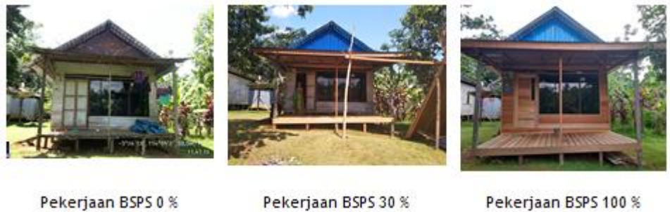
Gambar 3. 99. Realisasi Pekerjaan BSPS dengan Progress 0 %, 30 % dan 100 % Ta. 2018 di Kabupaten Banjar
