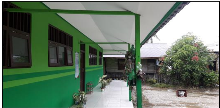
Gambar 3. 19. Rehabilitasi Berat SDN Tatah Pemangkih Baru, Tatah Makmur
